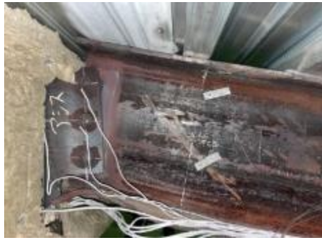
写真3 接合部の損傷状況
