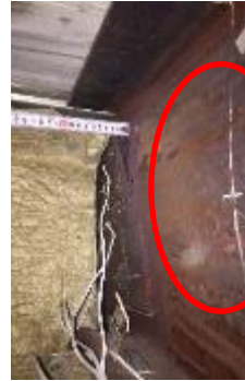
写真4 小梁ウェブの損傷状況
