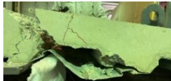
写真6 溶接金網破断部分のデッキプレートの損傷状況
