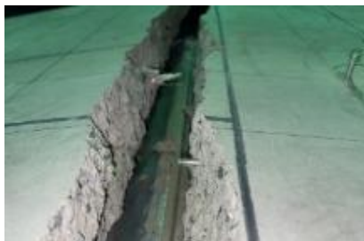
写真5 溶接金網の破断状況
