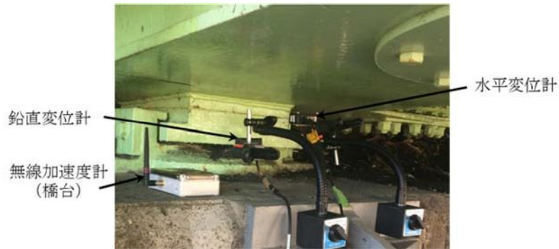
(b) 可動支承計測
