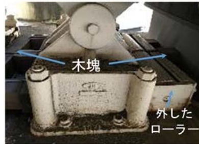
(c) 補修した脱落鋼製支承
