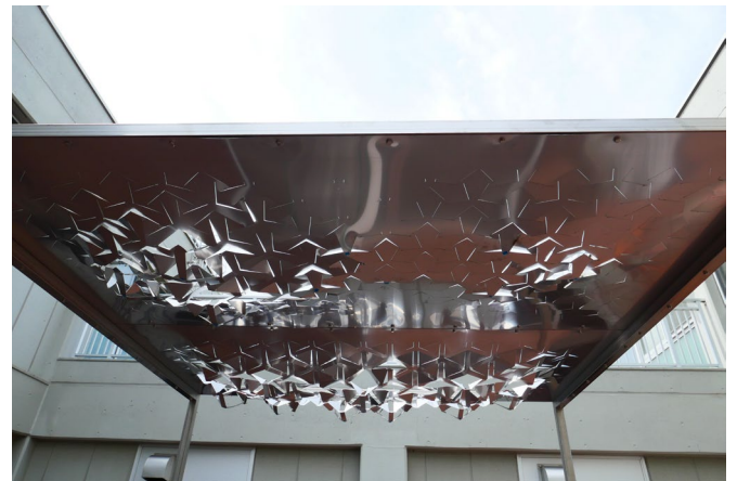
図 1.2 オーゼティック構造の自由懸垂曲面
