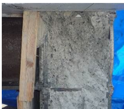
内部コンクリート
