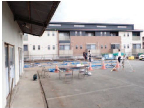
Photo. 4 実験場の様子
