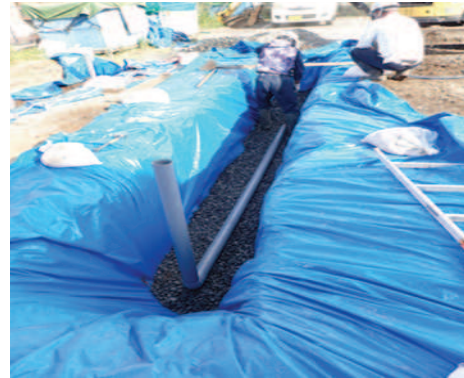
Photo. 6 フィルタ材敷設後
