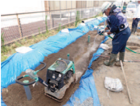
Photo. 10 建設発生土と鉄鋼スラグ混合の様子
