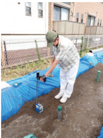
Photo. 11 軽量簡易動的コーン貫入試験の様子
