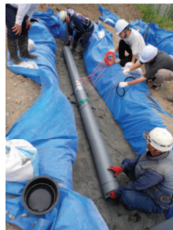
Photo. 7 掘埋設管設置状況
