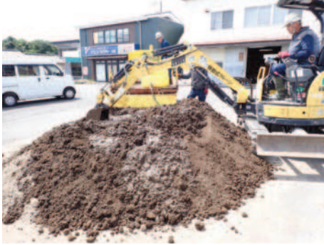
Photo. 9 建設発生土と鉄鋼スラグ混合の様子
