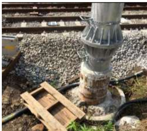
図 2 電車線柱基礎の例
